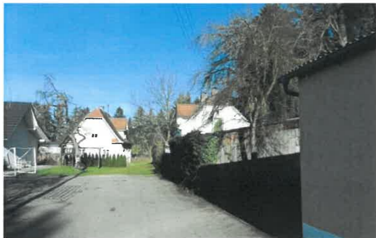
Abb. 4 Gebäudebestand von Süden auf Fl.- Nr. 143/2
